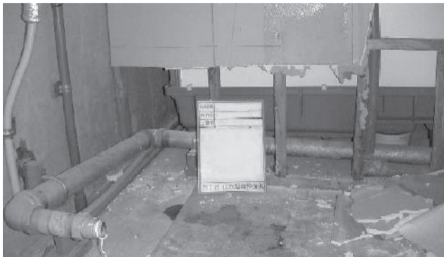
住戸内排水管更新工事の例
