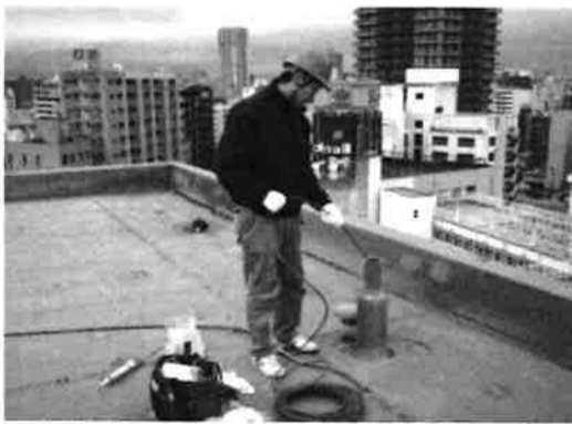
屋上からの作業
