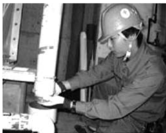
受水槽廻り配管類点検
